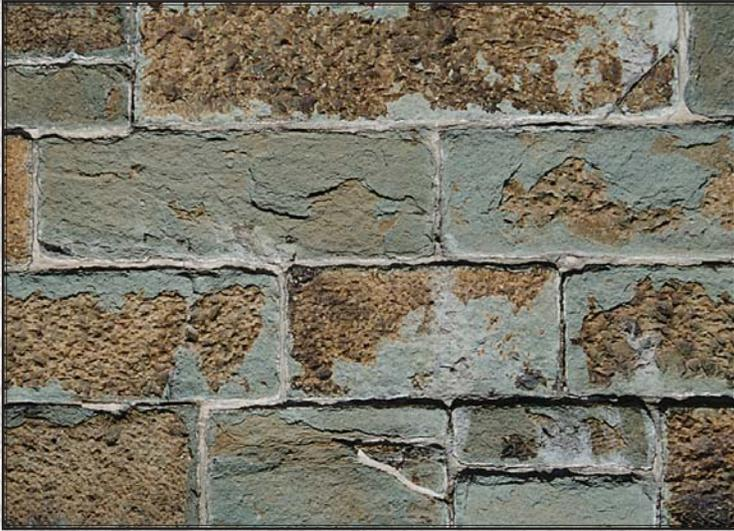
Site d'intérêt 5 – **l'arrière du Palais Montcalm.** Ce mur a été recouvert en 2007 avec un appareil assisé de **dolomie Adair Marble** provenant de l'Ontario.
