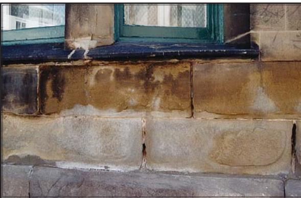
Grès de Bouctouche altéré : écaillage et désagrégation sableuse, oxydation rouille et absorption de suie noire.
